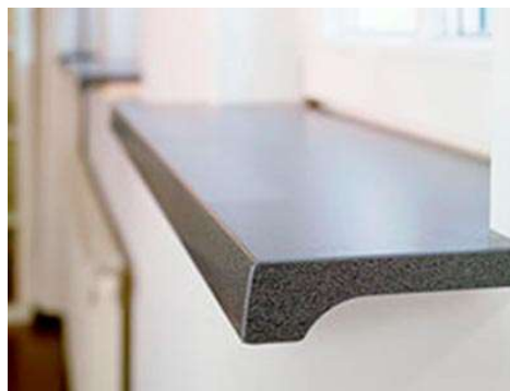
Figura 14: Peitoril de uma janela no interior da edificação.
