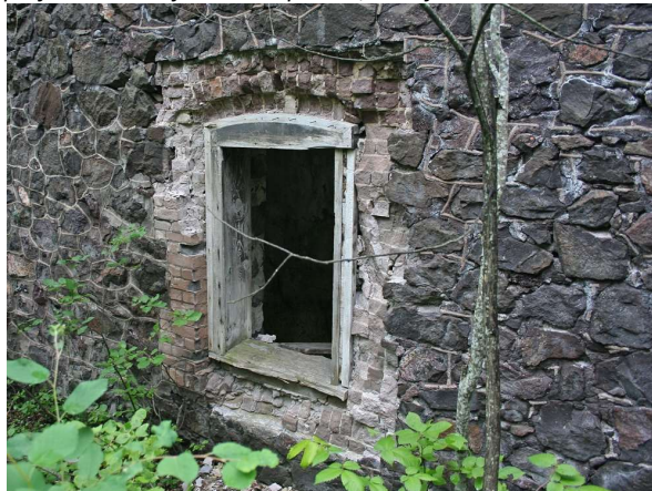
Figura 4: Janelas profundamente fixadas na parede, uma forma de evitar o contato direto do vento.
